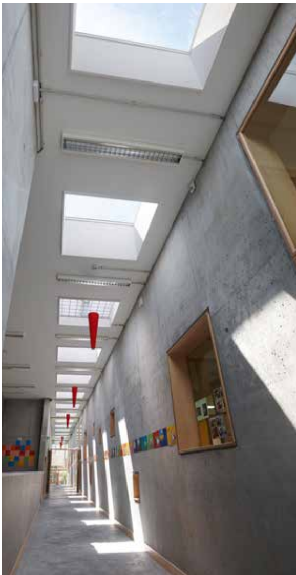
▲ Kindergarten mit Skylux® Lichtkuppeln - Brüssel - B
