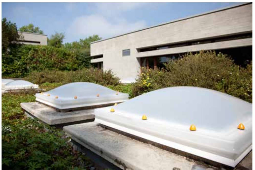
▲ Dachsanierung mit Skylux® Lichtkuppeln - Zug - CH
